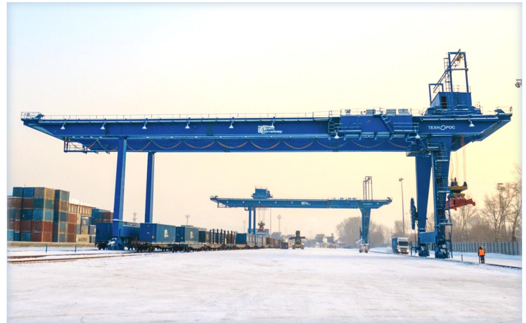
RMG-container cranes 45-42/10/5,5-12,5-A6
